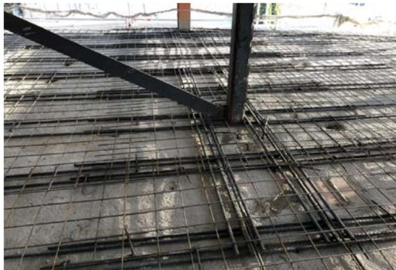
Figura 9: Ejecución en obra del refuerzo de negativos en nervios y pórticos. Se observan también los conectores recibidos con resina en los nervios
