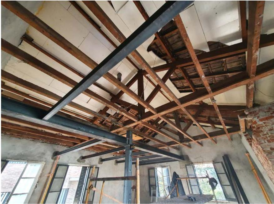
Figura 9: Apoyo de la estructura de acero en muro a distinto nivel del existente
