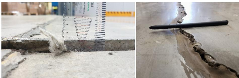
Figura 8: Lesiones graves en soleras interiores
