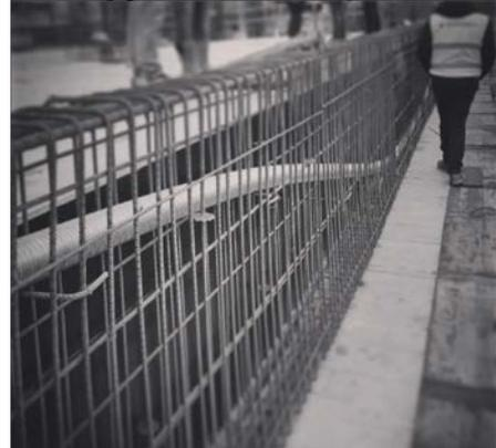
Figura 11: Sección tipo de viga postesada
