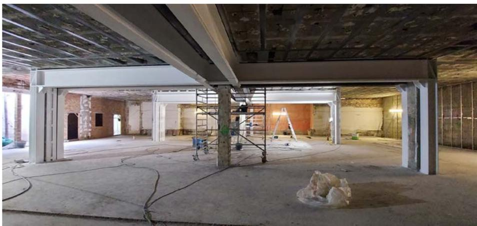
Figura 14: Pórticos metálicos ejecutados, previo a demolición de soportes a apear
