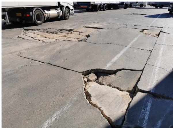
Figura 9: Lesiones graves en soleras exteriores
