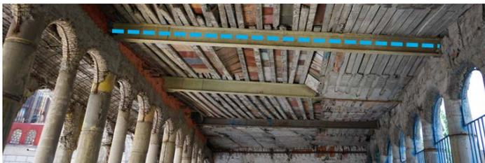
Figura 20: Viga a reforzar de planta baja de Salón parroquial exterior
