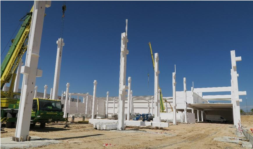
Figura 1: Vista de nave industrial en ejecución: ejecución de pilares
