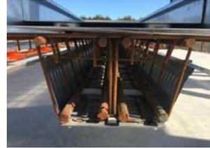
Figura 4: sección tipo de una viga Comflor
