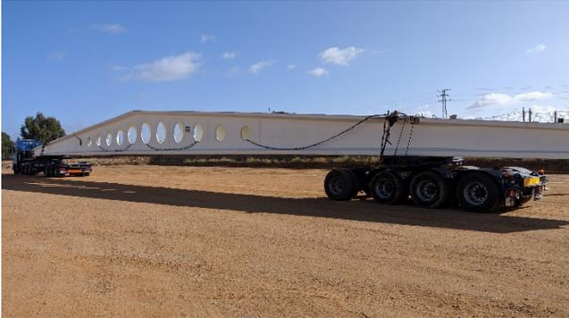
Figura 6: Transporte de viga delta. Imagen cedida por Pretersa-Prenavisa
