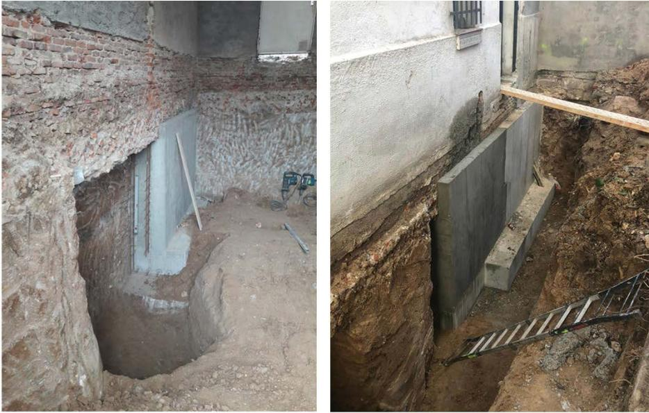
Figura 8: Ejecución de muros por bataches por el interior y por el exterior
