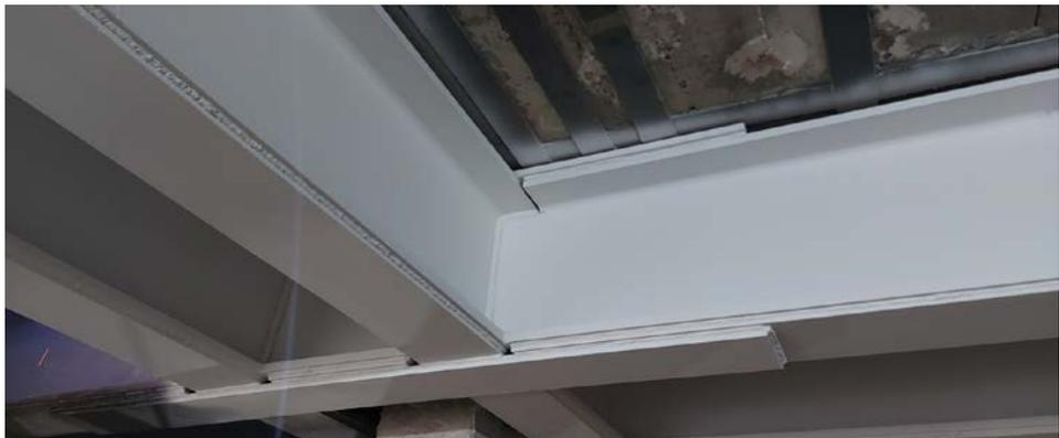
Figura 13: Detalle de la unión entre los dos pórticos ortogonales durante la ejecución de la obra. Se observa la ausencia de una soldadura de las alas superiores que posteriormente fue subsanada
