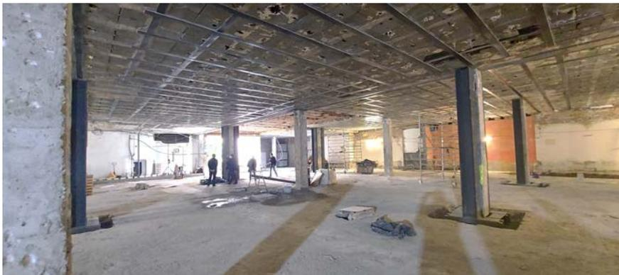
Figura 10: Refuerzos de fibra de carbono colocados en el forjado reticular
