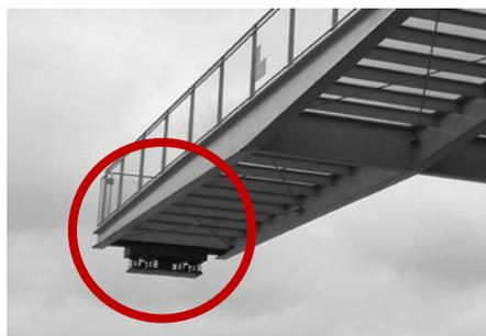
Figura 4: TMD instalado en el Centro Botín (Santander)
