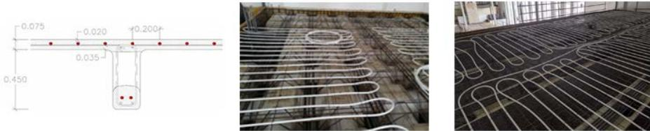
Figura 17: Incorporación de sistema de climatización en forjado
