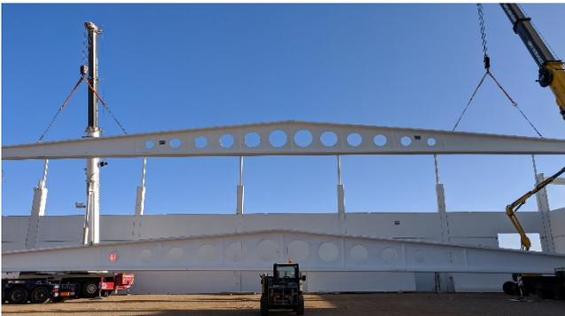
Figura 7: Disposición en obra de viga delta. Imagen cedida por Pretersa-Prenavisa
