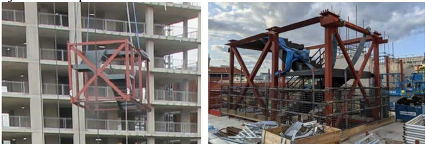
Figura 10: componentes volumétricos en los núcleos de escalera
