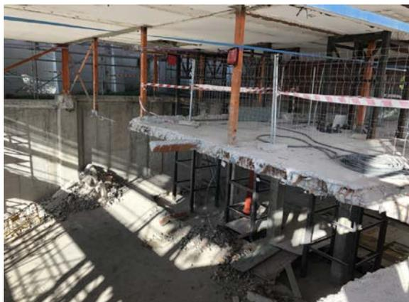
Figura 14: Vista desde el nivel de suelo de baja, con los tirantes del pórtico del eje “C” colgados de la cubierta y el forjado de suelo de baja, parcialmente demolido
