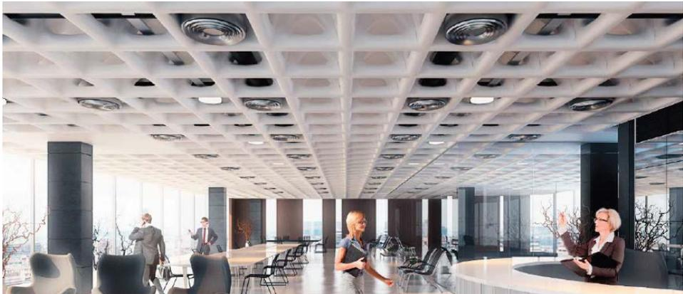
Figura 7: Imagen 3D de forjado bidireccional con perforaciones
