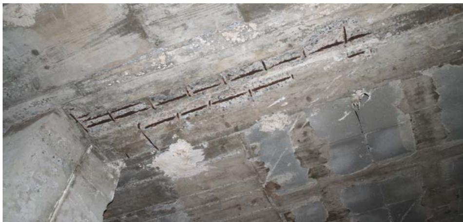
Figura 7: Daños de oxidación en las armaduras del forjado reticular en el momento de la intervención
