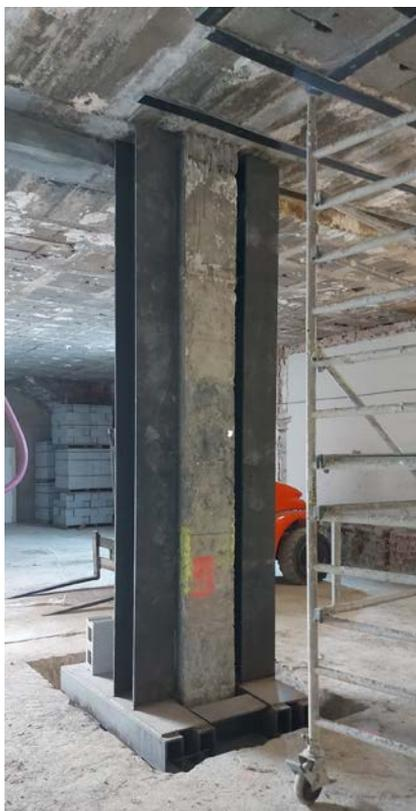
Figura 12: Nuevos soportes metálicos y encepado de vigas armadas.
