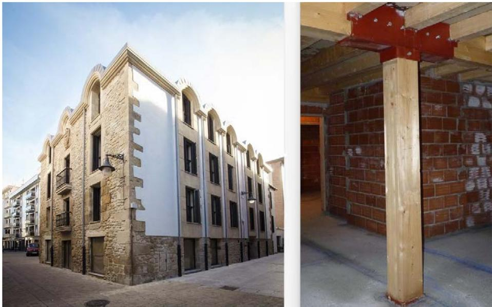
Figura 1: Fin de obra rehabilitación casa Kareaga / Figura 2: Compresión perpendicular
