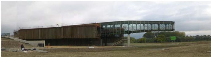
2003. Centro de Interpretación de la naturaleza. ATARIA. Salburúa. Vitoria. El mirador tiene un vuelo de casi 20m, realizado con una estructura mixta de madera (LVL), acero de diversos tipos y hormigón.
